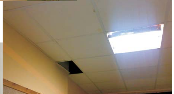
Paredes sin azulejos
